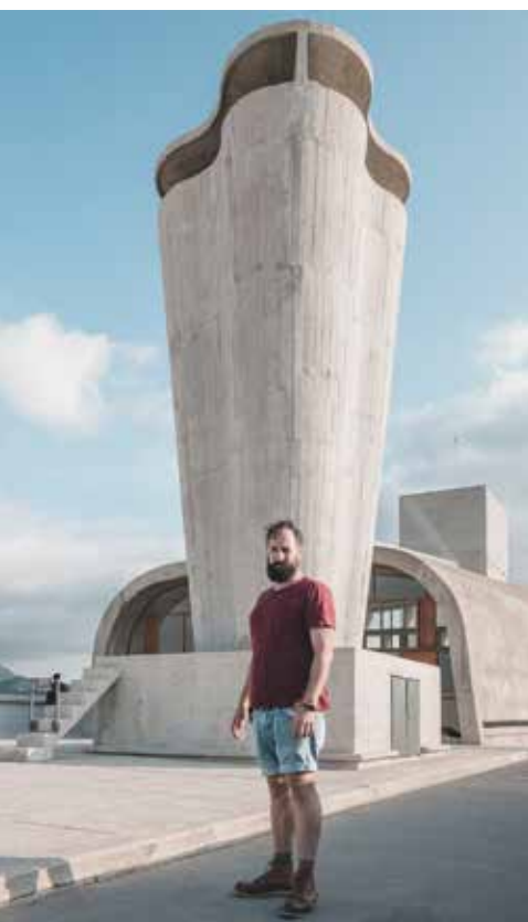
Der Fotograf Gregor Zoyzoyla auf dem Dach des ersten Brutalismus-Bauwerks im französischen Marseille.
