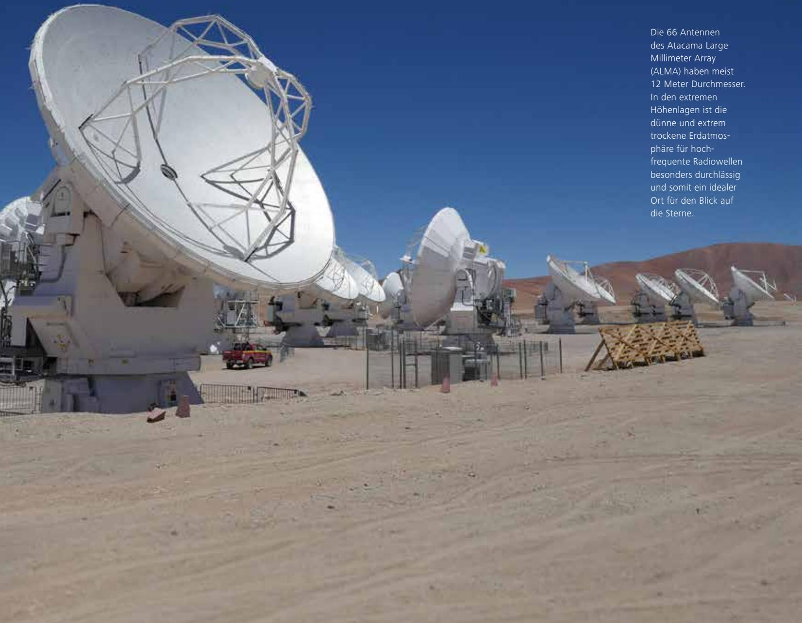
Die 66 Antennen des Atacama Large Millimeter Array (ALMA) haben meist 12 Meter Durchmesser. In den extremen Höhenlagen ist die dünne und extrem trockene Erdatmosphäre für hochfrequente Radiowellen besonders durchlässig und somit ein idealer Ort für den Blick auf die Sterne.
